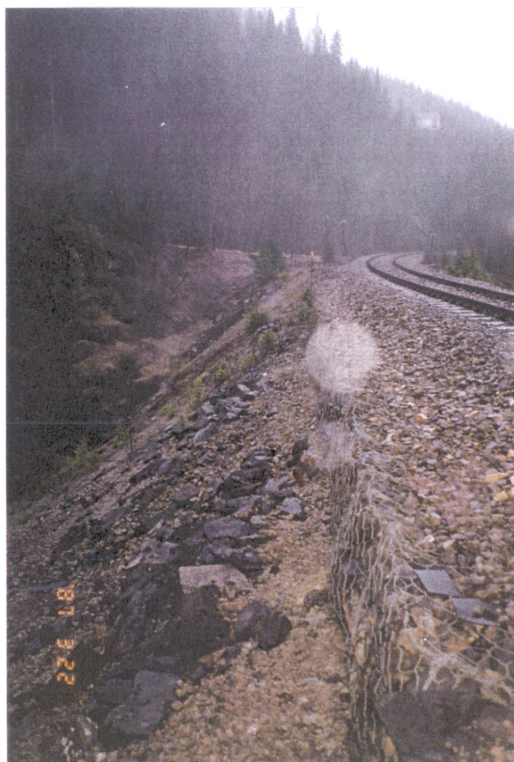
Fylling km.451.200 over Kvass-steinåga 13.01.02: Oppstrøms fyllingsskråning. For smalt formasjonsplan mot skråning. Gabioner som ballaststøtte. Erosjonsspor i overflate.
