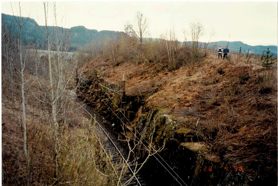
Bilde 2: Skjæring sett fra overgangsbru i retning fra Notodden
