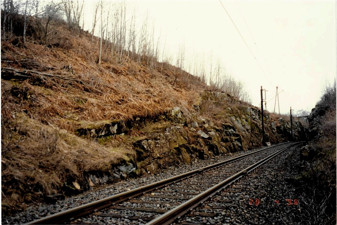
Bilde 1: Skjæring sett i retning mot Notodden (ca. km 141,900)
