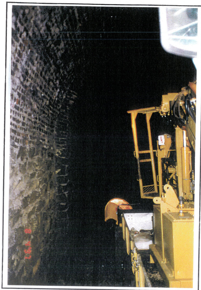
Lunnan tunnel. Teglsteinsutmuring inne i tunnelen.
