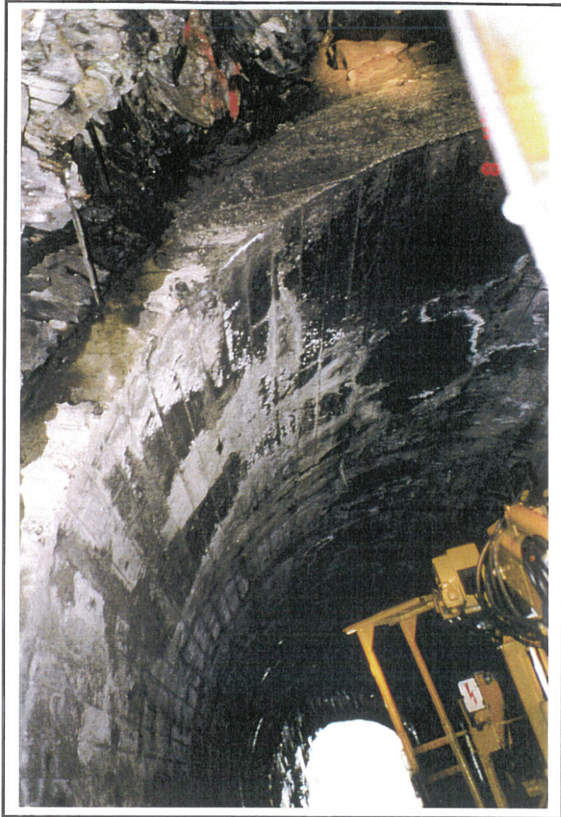
KoabjØrge tunnel. Utmuring inne i tunnelen.
