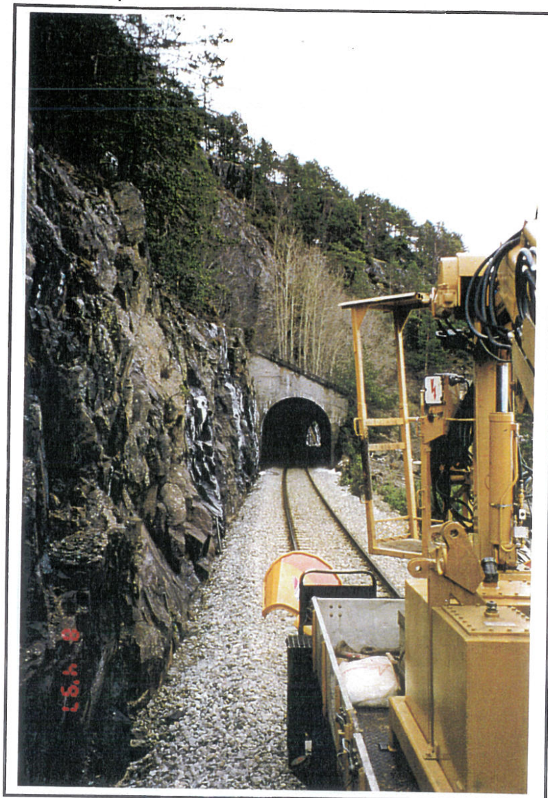
KoabjØrgen tunnel. TunnelpÅhugg vest (nord).
