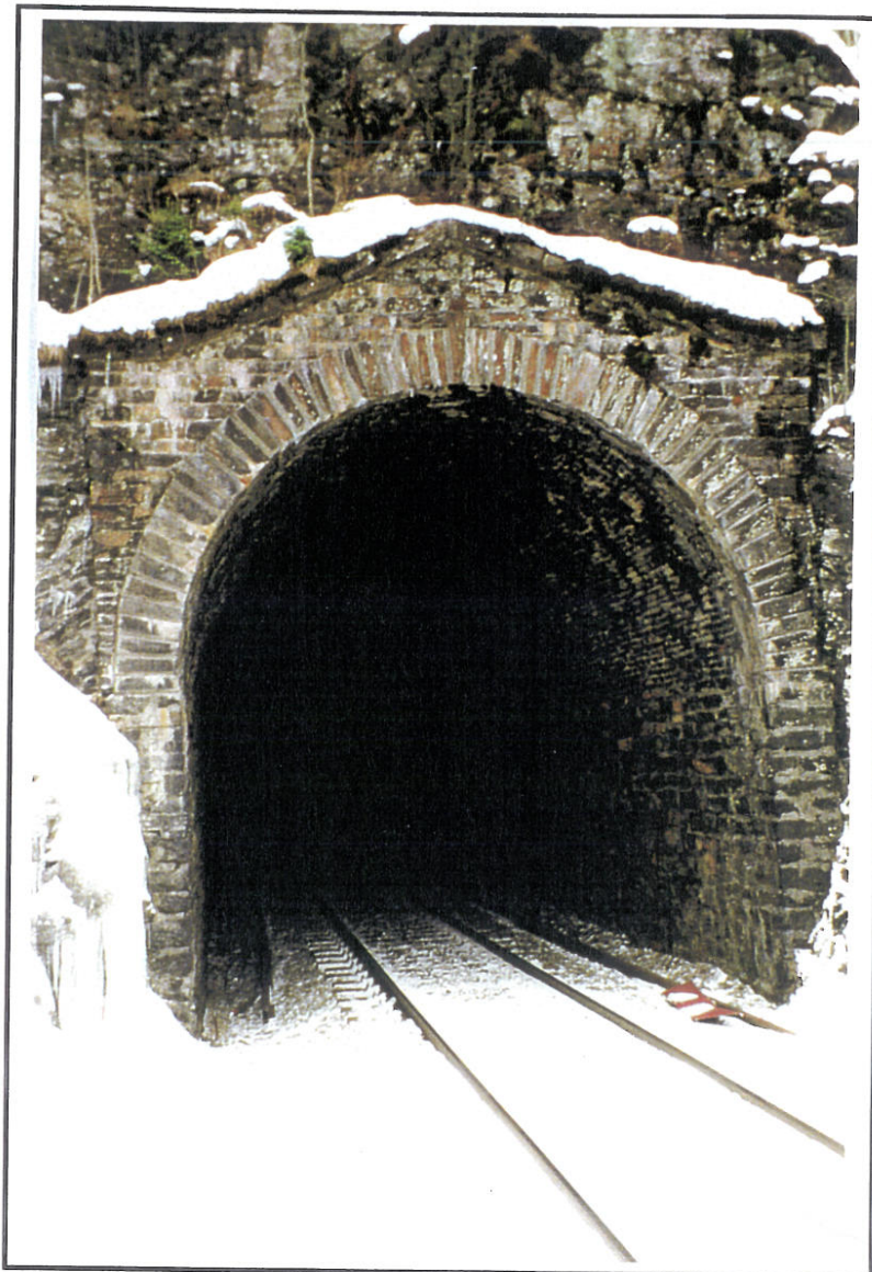
Lunnan tunnel. Tunnelpåhugg nord.
