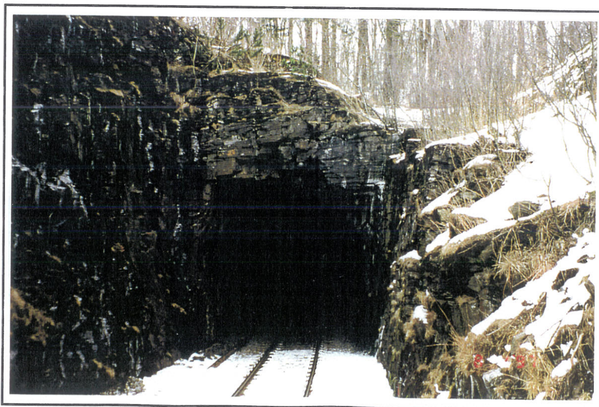
Lunnan tunnel. Tunnelpåhugg sør.
