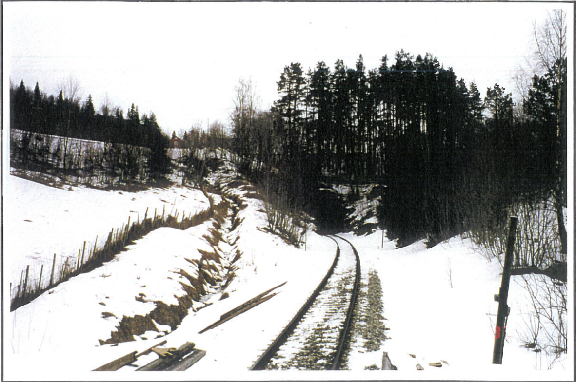
Lunnan tunnel. Tunnelpåhugg sør.
