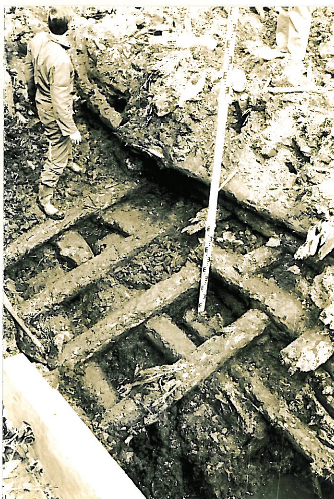
BILDE NR. 3 Nordre del av sjakt. Viser krysslaget tømmer på planskisse, tegning nr. 12054-11
