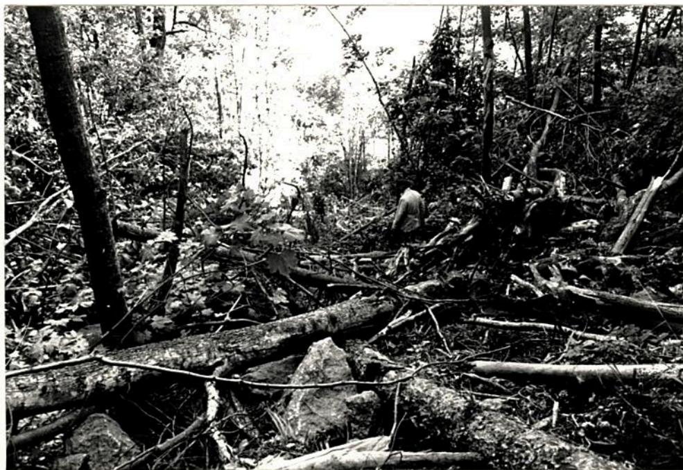
3. Sett ned mot jernbanen. 10 m bred gate i skogen etter raset.
