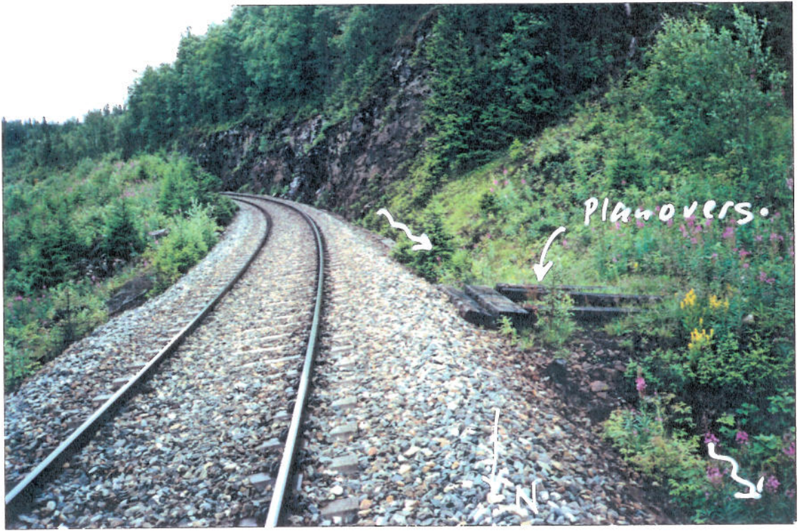
FJELLSKJÆRING I SYD
