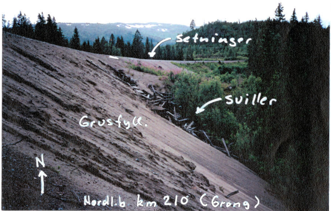
FYLLING - HØYRE SIDE Fyllingsutvidelse med grus.
