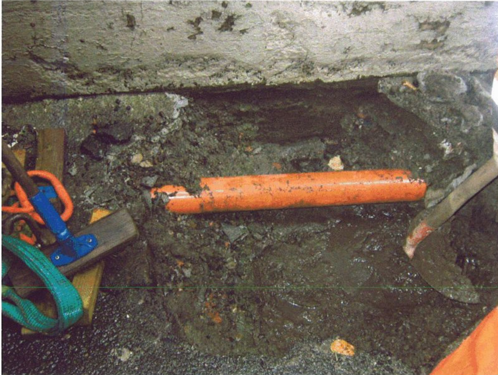
Figur 2: PG2, midt i Rådhusmauet. Grunnmuren (blokker) er fundamentert direkte på antatt berg, ca. 0,3 m under dagens terreng.
