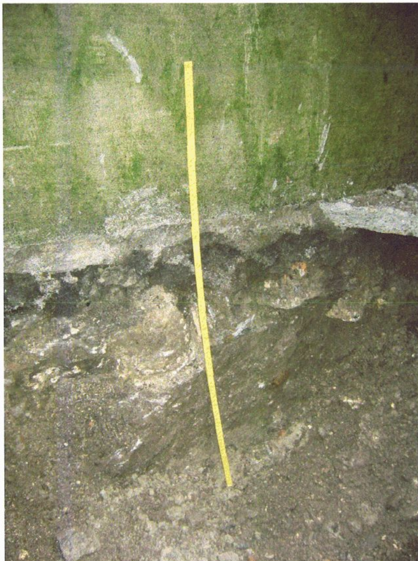
Figur 3: PG3, innerst i Rådhusmuget. Grunnmuren består av blokker. Gravingen ble stoppet mot et gammelt VA-rør, ca. 0,2 m fra veggen ca. 0,6 m under terreng. VA-røret ligger i morene, og det ser ut som om grunnmuren er fundamentert på samme type masser. Dybde til berg er ikke kjent.
