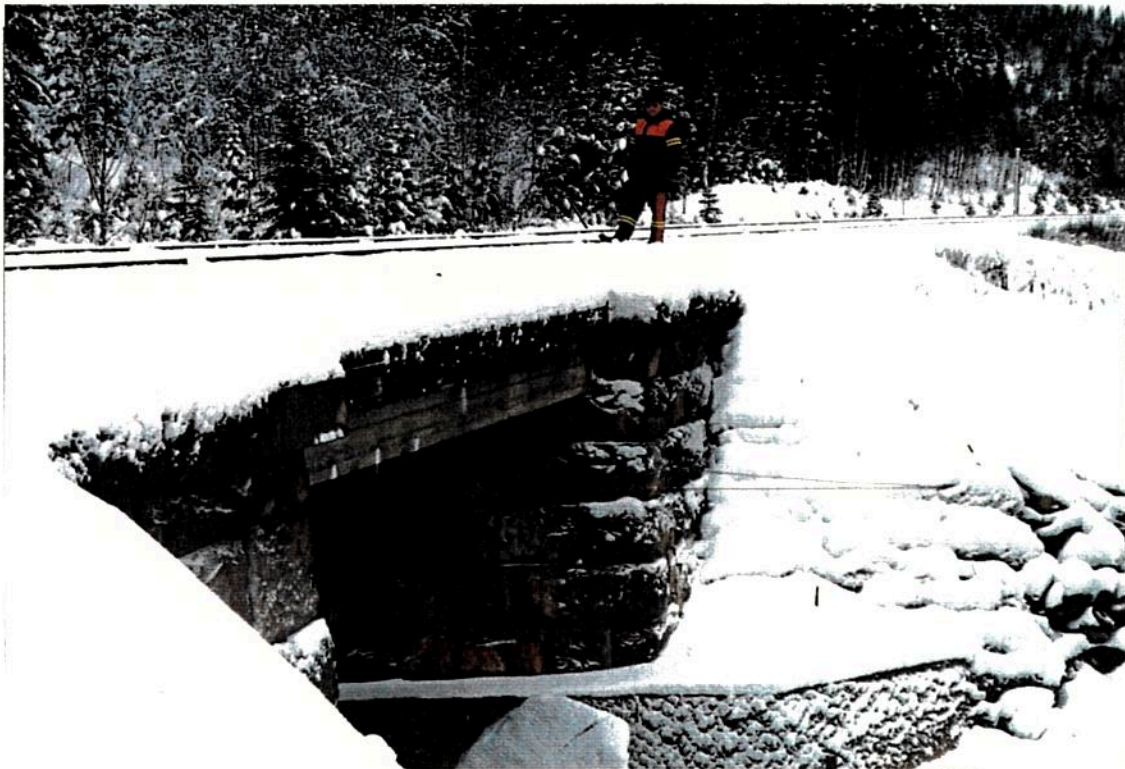
Fig.3.10 Høydefeil i overgang bru/fylling
