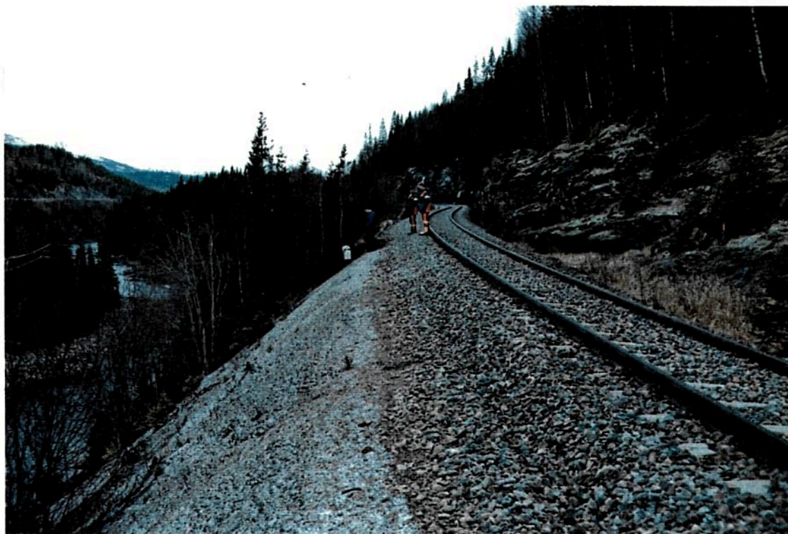
Fig.3.11 Problemområde med høy fylling i sterkt skrånende terreng.
