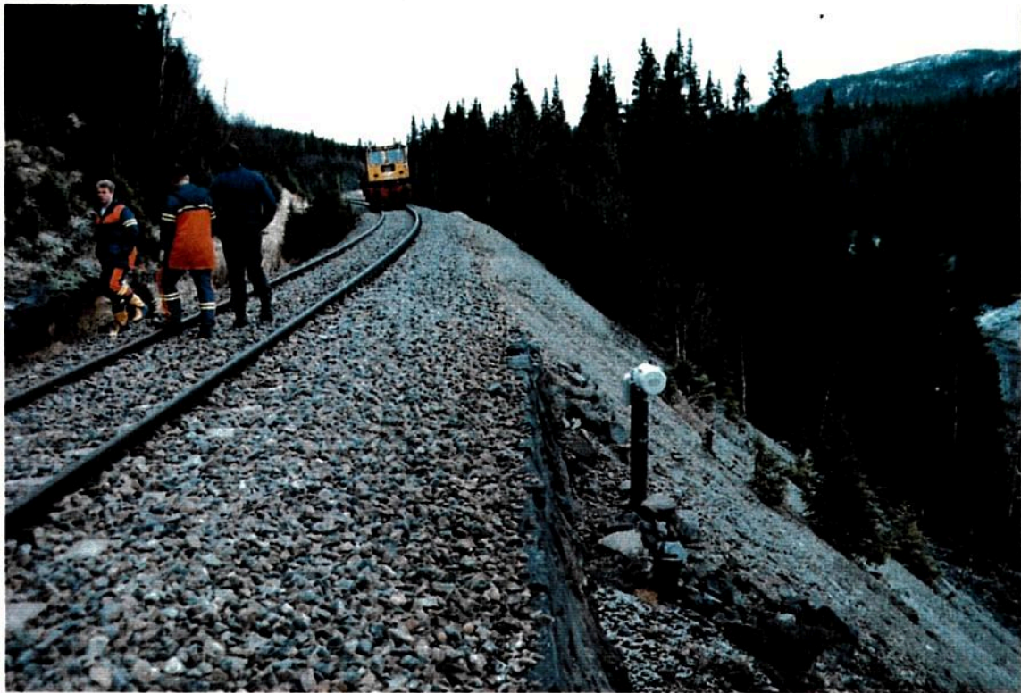
Fig.3.12 Støttemur som hinder mot utrasing
